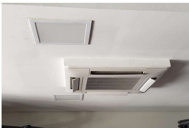
Figura 14 – Ar condicionado e lâmpada LED.
