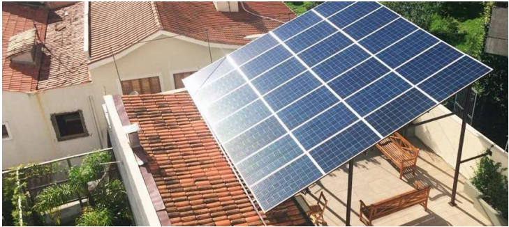
Figura 16 - Painéis solares instalados em um telhado metálico.
